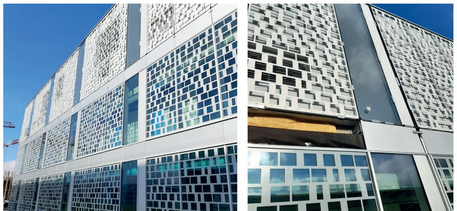
Institut de recherche SERVIER à Paris-Saclay : réalisation de cassettes en aluminium post anodisées avec structure métallique
