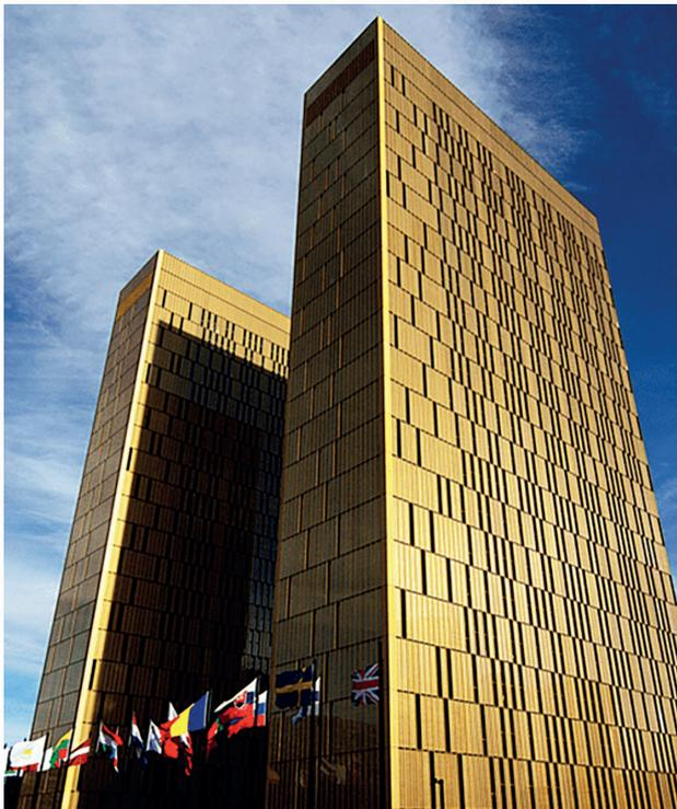
Cour Européenne de Justice à Luxembourg : réalisation de panneaux de finition en aluminium avec revêtement anodisation "or"
